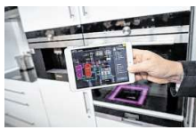
In E-Häusern, wie diesem in München, läuft alles übers Tablet. BILD: DPA
